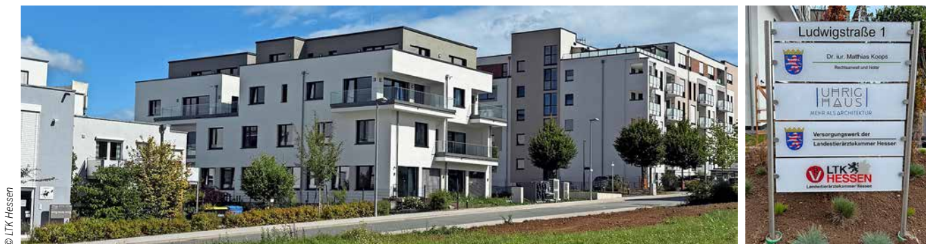
Die neue Geschäftsstelle der LTK Hessen und des Versorgungswerks in der Ludwigstr. 1 in Idstein
